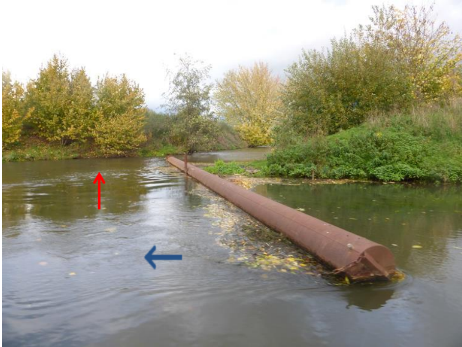
Anbindung des Altarms an die fließende Erft (roter Pfeil) mit „geöffnetem“ Schwimmbalken. Blauer Pfeil = Fließrichtung der Erft
