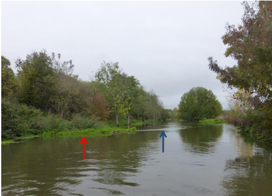
Blick mit der Strömung auf den Strömungslenker (roter Pfeil), der den Stromstrich (blauer Pfeil) in Richtung rechtes Ufer lenkt. Position direkt oberhalb der angelegten Sekundäraue, 05.11.2019.
